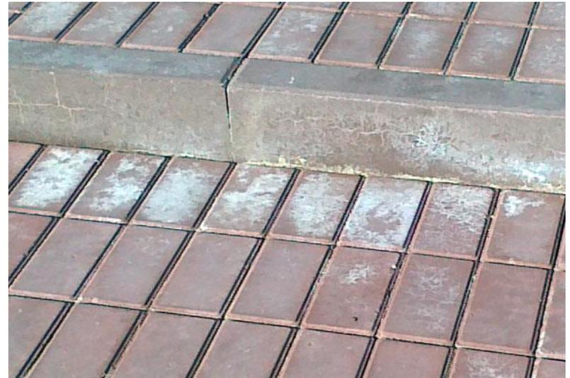
Главными причинами появления высолов на тротуарной плитке при хранении продукции на складе, а также после ее укладки являются водорастворимые соли, содержащиеся в сырьевых компонентах: цементе, песке, воде и добавках. Капиллярный подсос воды, имеющий место после укладки, также способствует образованию высолов.
